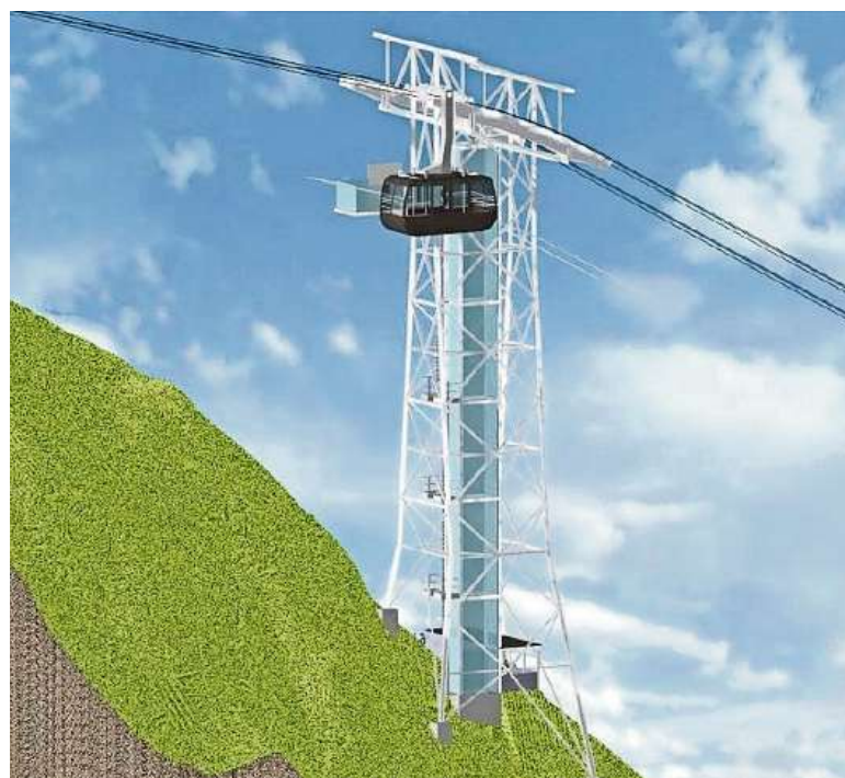
Eine Plattform, ein Lift in der Stütze und ein überdachter Ausgang: So könnte der Zwischenausstieg Cungi gemäss Visualisierung aussehen. (ZVG)
