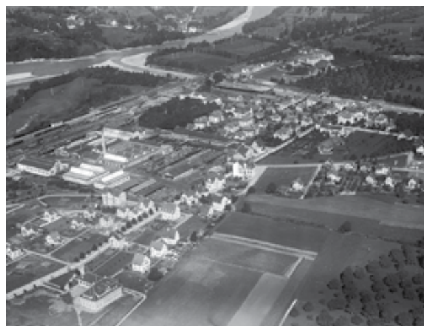
07.07 Landquart 1923 Il lieu ch'è sa sviluppià pir l'onn 1858 è caracterisà dal complex d'edifizis dal lavuratori principal da la Viafier retica e da las chasas d'abitar dals employads.
