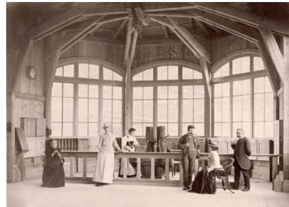
19.06 Bigl da cura en la halla da baiver da l'hotel Neues Stahlbad a San Murezzan. Fotografia or da l'album da la construcziun 1892.
