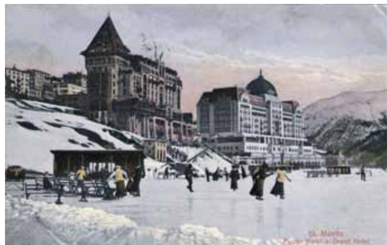
24.07 Durant la Belle Époque è il svilup dal turissem stà caracterisà da la construcziun da gronds hotels ch'han midà en moda radicala l'aspect architectonic ed urbanistic dals lieus da vacanzas. Il maletg mussa il Hotel Palace ed il Grand Hotel a San Murezzan enturn l'onn 1910.
