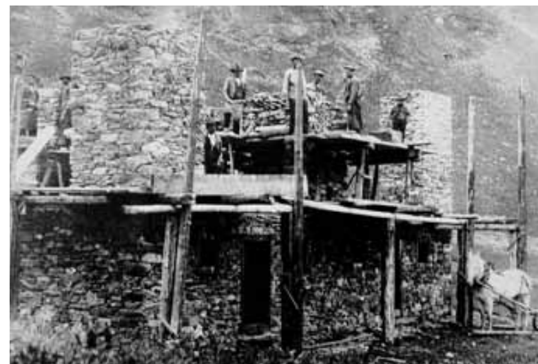
40.05 Lavur cumina durant la construcziun d'ina stalla en la Val Stussavgia 1914/18.
