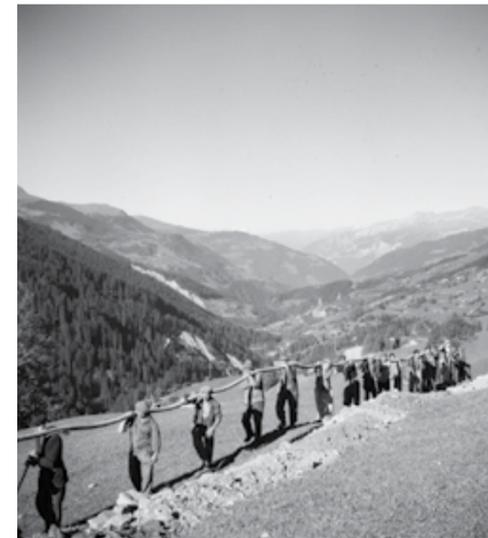
41.11 Le linee interrato sostituirono quelle aeree, spesso soggette a guasti. Operai posano la linea telefonica Coira-Arosa, 1946.
