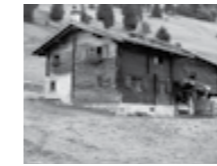
Küblis, Runggalina ■ Vielzweckbau
