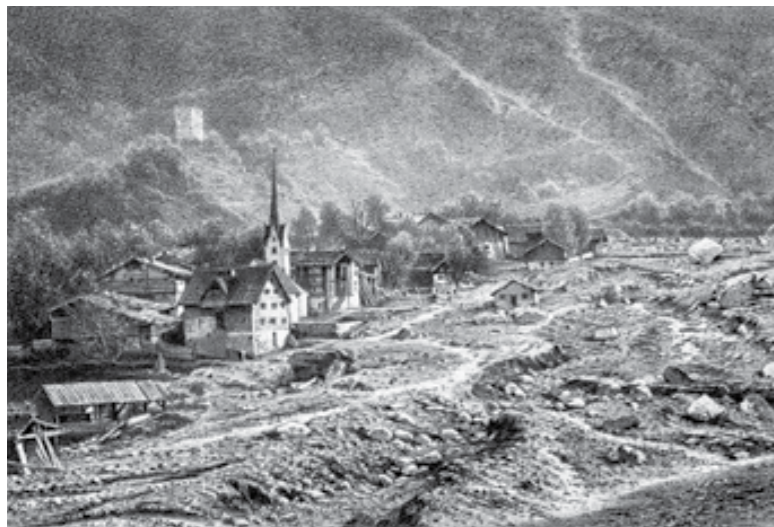
12.07 Verrückung von Zignau (Ringgenberg) im Zuge der Hochwasserereignisse 1868 Die im Zusammenhang mit dem Lokalangenehm des Bündner Forstinspektors Johann Coaz entstandene Abbildung kann als zuverlässig eingestuft werden.
