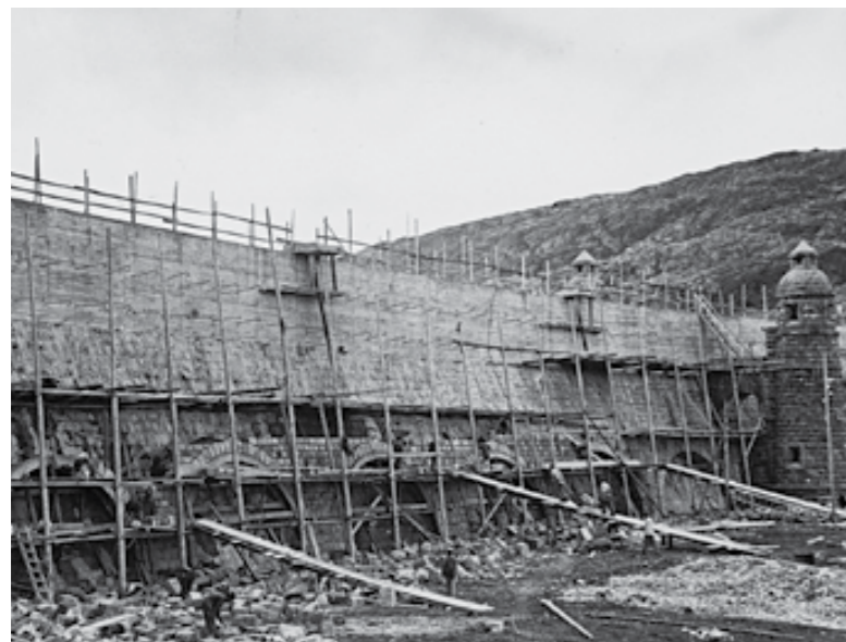
18.06 Die 1910 erstellte Staumauer des Lago Bianco (2234 m ü.M.) im Bau Mit der Gewichtsstaumauer wurden zwei natürliche Seen zusammengefasst. Im Lauf der Jahre konnte die Leistung des Kraftwerks wesentlich gesteigert werden, indem das Wasser durch eine Druckleitung in das tiefer gelegene Kraftwerk Palü geleitet und später auch die Staumauer erhöht wurde.
