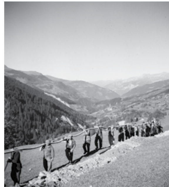
41.11 Telefonkabel ersetzen die störungsanfälligen Freileitungen. Arbeiter beim Verlegen des Telefonkabels Chur–Arosa 1946.
