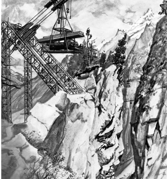
Funicolare per trasporti pesanti sul cantiere della diga di Albigna. Disegno di Georg Peter Luck, 1957.
