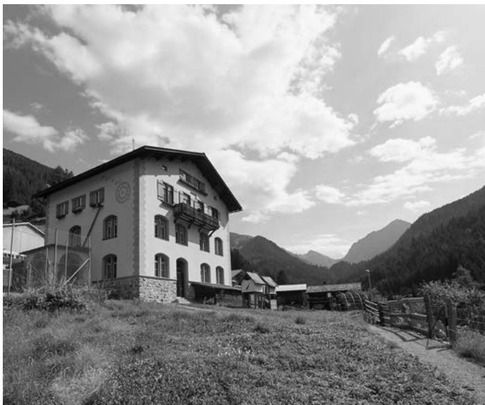
Das «Kulturhuus Schanfigg» ist im ehemaligen Schulhaus in Langwies untergebracht. Foto: Dominic Richard.
