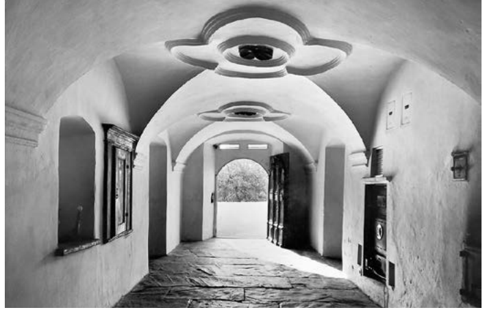
Gewölbter Sulèr im Grosshaus von Sprecher, Luzein, 1907 (1958 Umbau durch Rudolf Olgiati).
