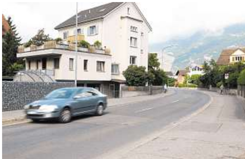
Ein Bahntrasse als Strasse: Die Churer Oberalpstrasse folgt dem Verlauf der einstigen RhB-Bahnstrecke nach Reichenau.
