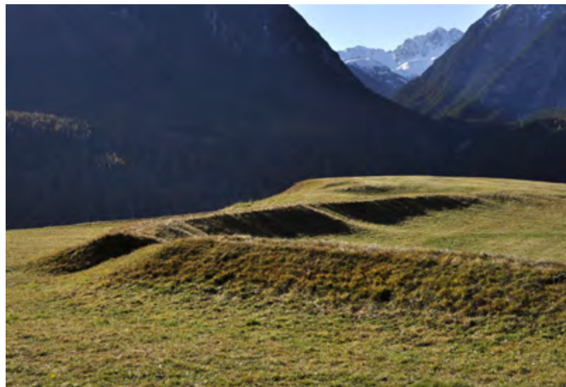
Bewässerungskanal auf Damm, Russonch, Scuol, 2010. Foto: Susanne Grimm
