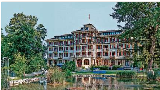
Wiederbelebung nach Niedergang: Das «Kurhaus Bergün» wurde umsichtig renoviert.
