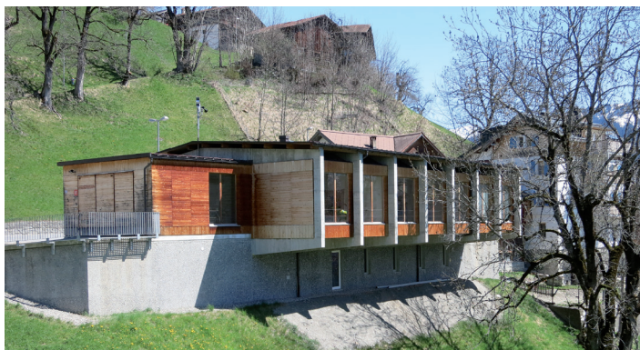
Neues Gemeindezentrum Castiel (2002) von Jüngling und Hagmann.
