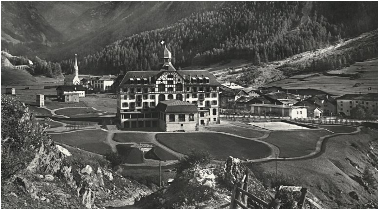
Frühe Gesamtansicht des Kurhauses Bergün. Vom späteren Hotelpark sind erst die Grünflächen und die Wege angelegt.
