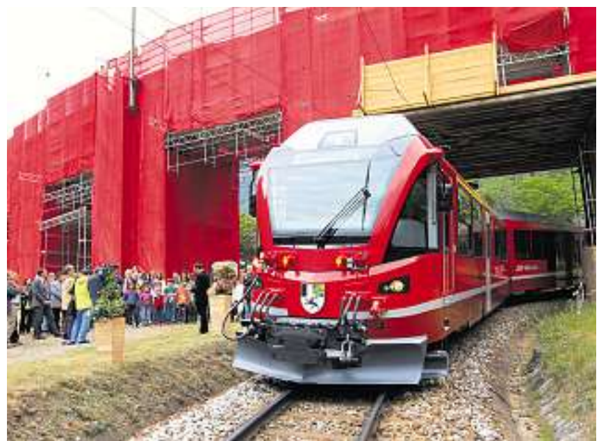
Zugtaufe unter dem verhüllten Kreisviadukt: Am «Tag der offenen Baustelle» in Brusio erhält ein Allegra-Triebzug den Namen «Alberto Giacometti». Bild RhB
