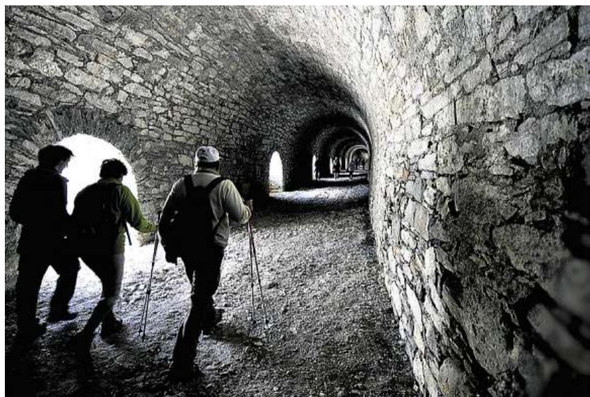
Spektakulärer Lawinenschutz: Carlo Doneganis Galerie am Splügenpass kann heute wieder gefahrlos begangen werden. Bild Jano Felice Pajarola
