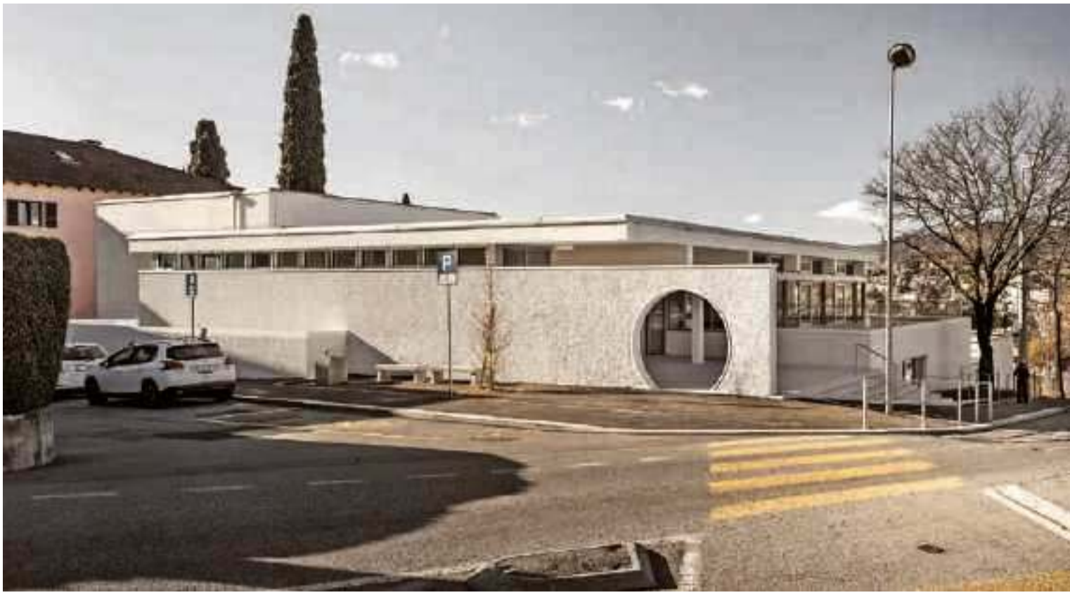
Dopo l'ampliamento lo stabile di via Cassone ospita il Punto Città e spazi per la scuola elementare. (Marcelo Villada)
