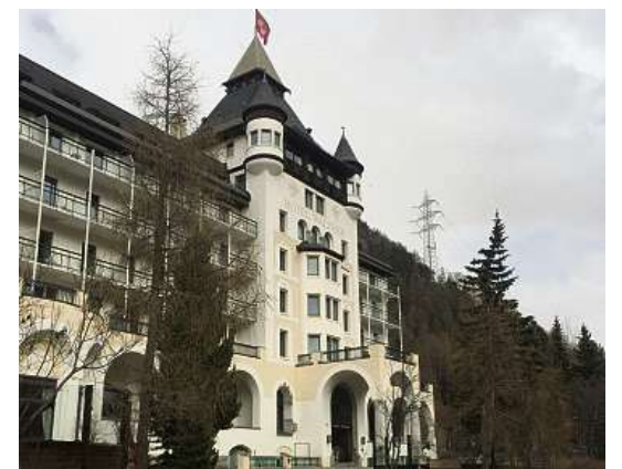
Von Ende März bis Ende Juni 2017 bleibt das Hotel «Walther» wegen Umbau geschlossen. (NM)
