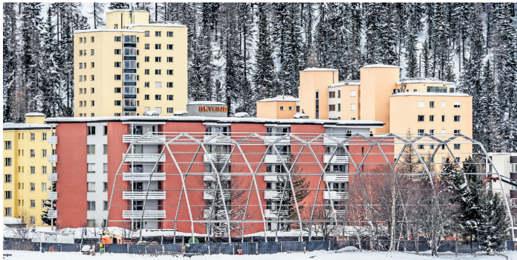
Es handelt sich nicht um eine neue Eishalle, die auf der «Zirkuswiese» in St. Moritz gebaut wird. Aber auffällig ist sie – die riesige und fast sechsstöckige Konstruktion. Umso mehr, als es kaum Informationen dazu gibt. Foto: Daniel Zaugg
